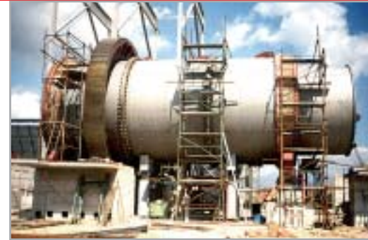
Монтаж мельницы для помола сырья Ø 5,4 x 11 м с камерой сушки.
