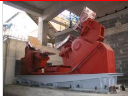
Segmentové ložisko před usazením bubnu mlýna
