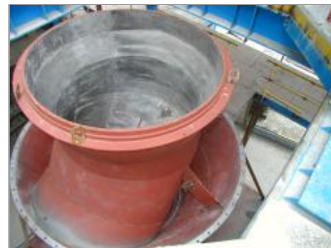
Montáž spodní části vzduchového třídíče
