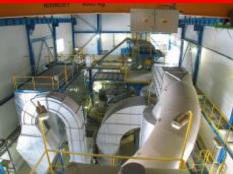
Filtr a dvojice odlučovacích cyklonů
