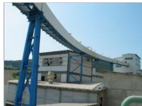
Doprava hotového produktu
