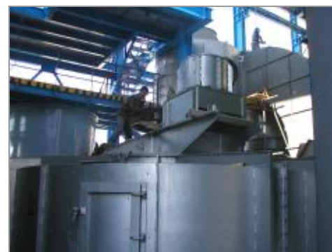
Montáž vzduchového třídíče
