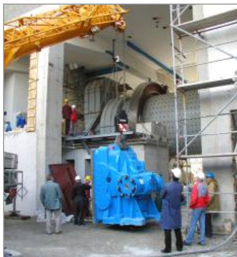
Nahoře a vpravo: Montáž pohonu mlýna
