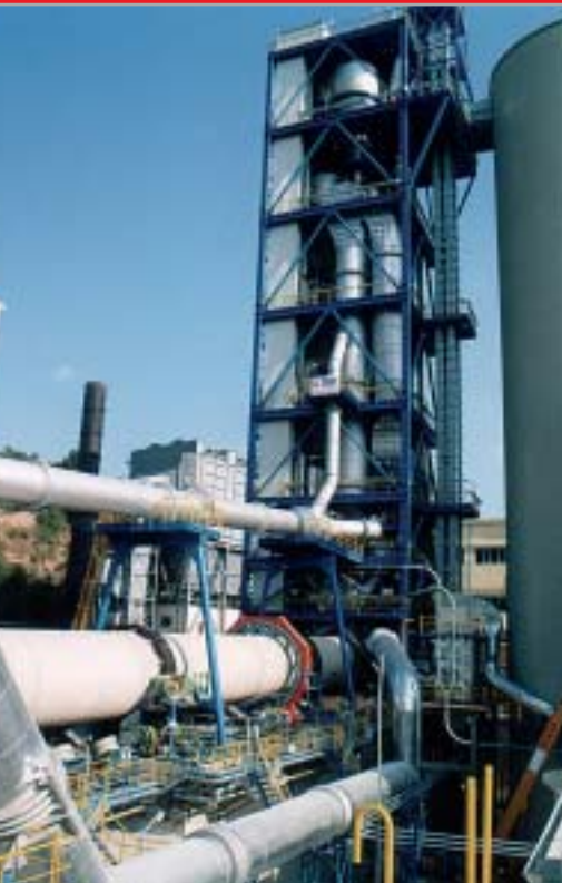
Печная линия 1100 т/сутки с системой декарбонизации KKN/AS с редукцией NO_x
