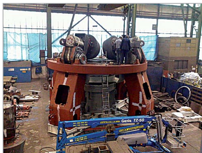
Установка маятников бегунов в подшипники
