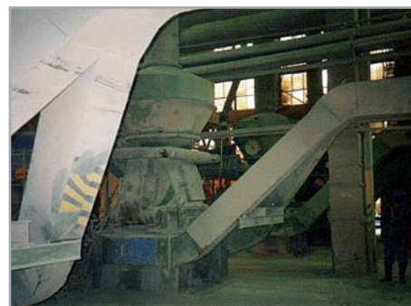
Старая мельница КТМ 1200 перед демонтажем и установкой новой мельницы на действующую раму основания
