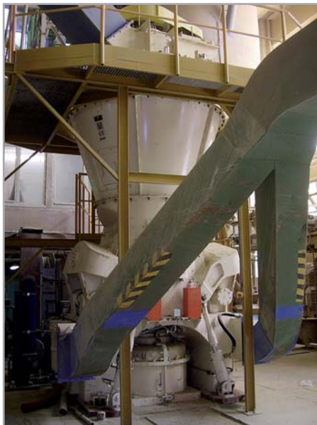
Новая мельница КТМ 1200 установленная на старой раме основания действующей мельницы КТМ на заводе заказчика – помол бентонита.
